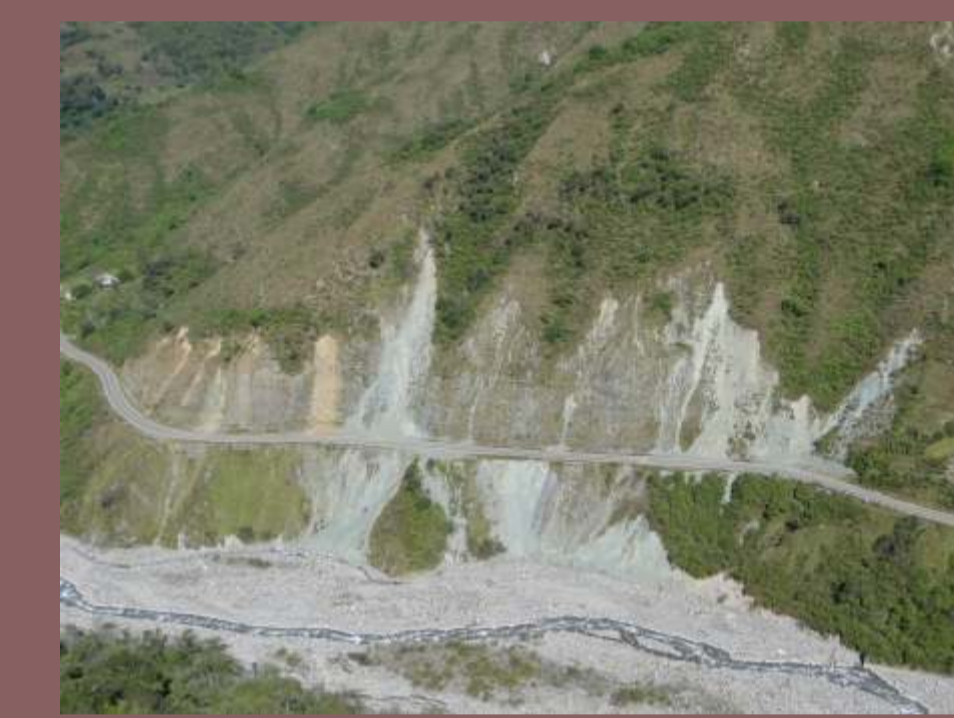
Area in frana interessante un importante asse stradale nelle Ande settentrionali argentine, al confine con il Cile.
