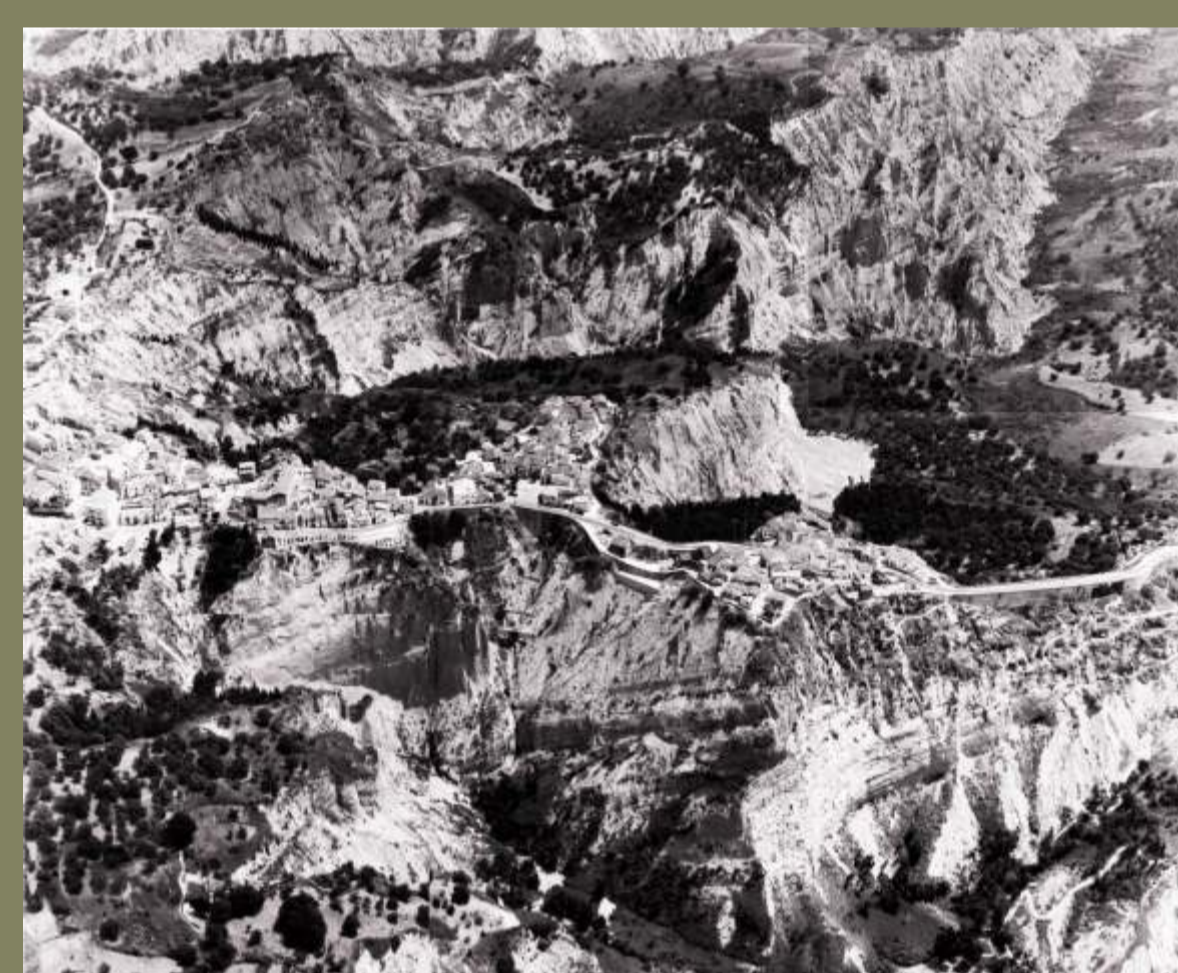
Veduta aerea dei versanti sabbiosi di Aliano intaccati da una spiccata erosione e da movimenti di massa.
